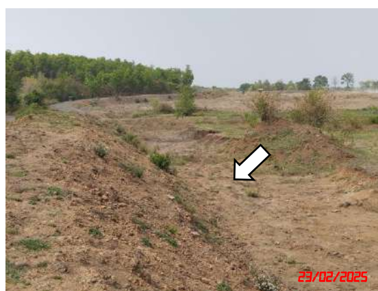
รูปที่ 7 ร่องลัดผลกระทบจากแรงสั่นสะเทือนตามแนวเขตหลักฐานที่ 8-10
